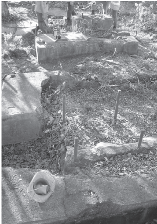
Figura 8. Restos de la usina durante el relevamiento arqueológico. Se pueden observar los bulones correspondientes a las bases de los motores.
