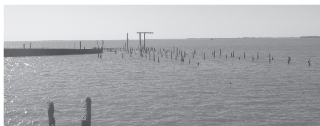
Figura 2. Muelle – Conjunto industrial. Vista hacia el oeste. A la izquierda perfil de una embarcación; a la derecha restos del muelle (pilotes de madera).
