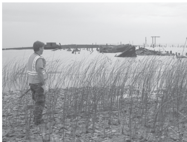
Figura 32. Restos de uno de los barcos fondeados y vista general del muelle en su estado actual desde el sureste.
