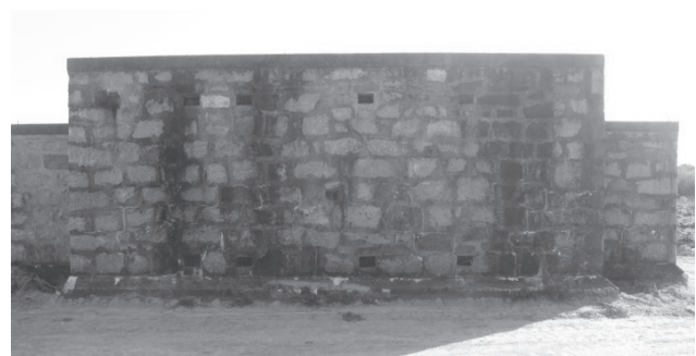
Figura 10. Vista noreste de una de las construcciones.
