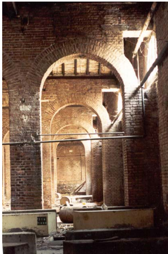
Arquería de ladrillo, circa 1910, Ex Bodega Arizu, Godoy Cruz, Mendoza
