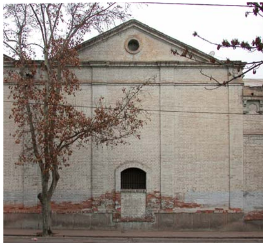
Detalle de fachada, Bodega Escorihuela, Godoy Cruz, Mendoza
