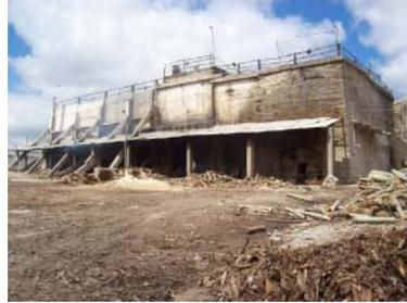
Para la construcción de los hornos no se utilizaron las elevaciones naturales del terreno, sino que estas fueron hechas artificialmente para el acceso de los camiones que llevan la caliza a la boca de carga.
