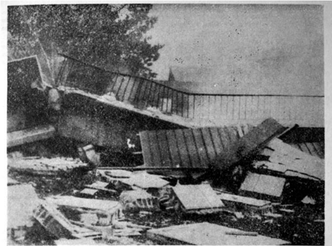
Voladura del Club de Bowling. Estado en que quedó el edificio sito en pleno centro de la zona montevideana de Carrasco.
